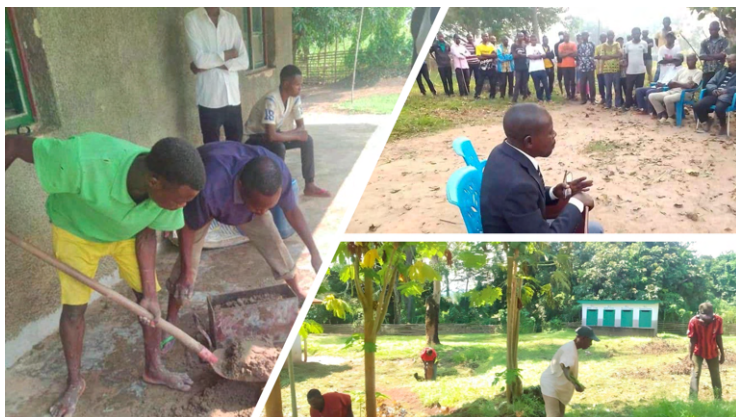
Travaux de réfection, assainissement et sensibilisation à Mutoy.
