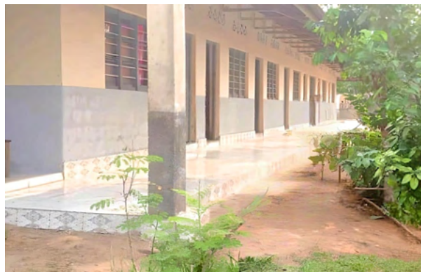
Une vue du presbytère rénové.
