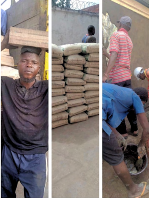
Travaux de rénovation du presbytère de Mutoy
